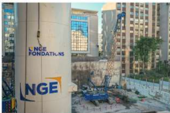
Le chantier se déroule dans un environnement extrêmement contraint.
