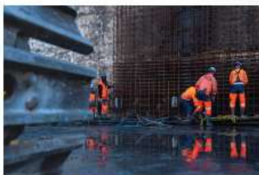
Préparation du ferrailage de la paroi moulée.
